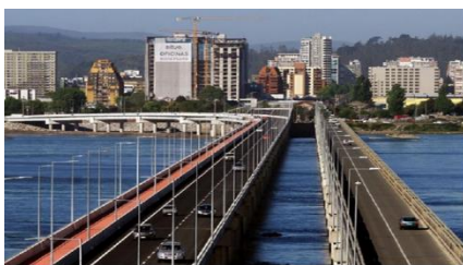
Figura 6. Puente Bicentenario-Chacabuco sobre río Bio Bio, De San Pedro hacia Concepción.
