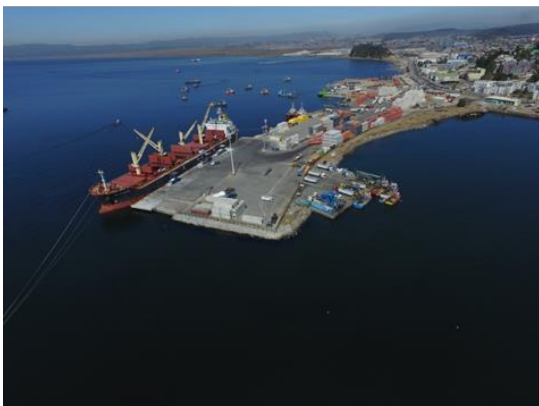
Imagen 3. Puerto de Talcahuano. Molo principal reconstruido luego de terremoto y tsunami 27/F/2010.
