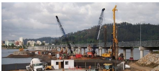
Figura 5. Proyecto Bicentenario, Puente Chacabuco, construcción cepas y enlace San Pedro-Concepción.
