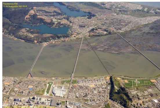
Figura 4. Puerto de Talcahuano. Muelle principal reconstruido luego de terremoto y tsunami de 27/F/2010.
