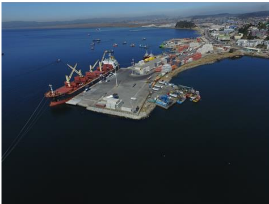
Imagen 3. Puerto de Talcahuano. Molo principal reconstruido luego de terremoto y tsunami 27/F/2010.
